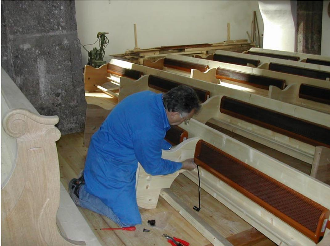
5. Montage: Kirchenbankstrahler montieren und Durchführung der Verbindungsleitung
