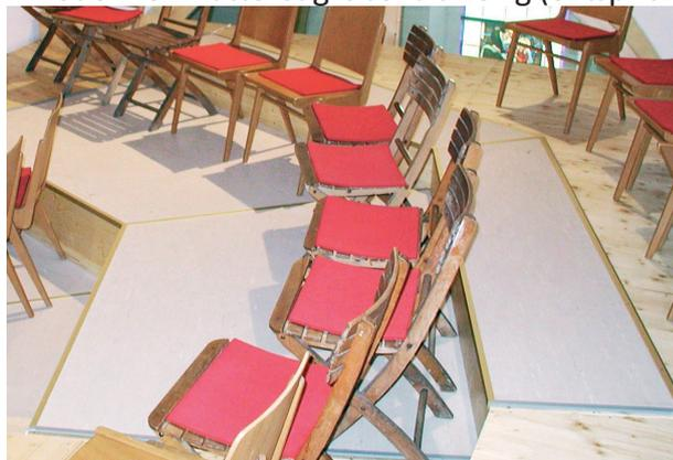
**Achtung:** Es ist sicherzustellen, dass die Bodenheizelemente nur bei ausreichender Wärmeabfuhr betrieben werden. Sämtliche Überlappungen, z.B. bei mehreren Bodenheizelementen oder Umschlagen einer Bodenheizmatte, führt zu einer Überhitzung - Brandgefahr. Eine Verlegung über Stufen oder Kanten ist nicht zulässig.
