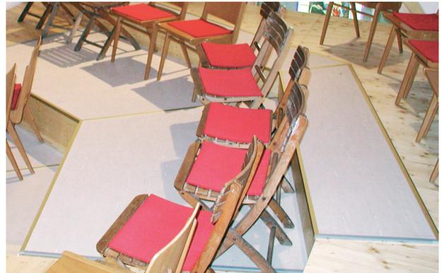
**Attention :** Il faut s'assurer que les éléments de chauffage au sol soient uniquement exploités avec une dissipation thermique suffisante. Tous types de chevauchements, par ex. en cas de plusieurs éléments de chauffage au sol ou le repliage d'un tapis de chauffage au sol conduit à une surchauffe - risque d'incendie. Une pose sur des marches ou des bords n'est pas autorisée.
