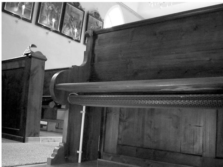
Doch nicht nur die Benutzer und Betreiber werden mit dem neuen Infrarot-Kirchenbankstrahler zufrieden sein. Auch der Elektroinstallateur profitiert von der einfachen und schnellen Montage. Der Netzanschluss erfolgt über ein Gerätestecksystem. Somit entfällt die zeitaufwendige Öffnung vor Ort.
